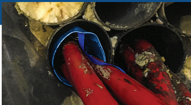
OKE paigaldamine mitme toitekaabliga.
