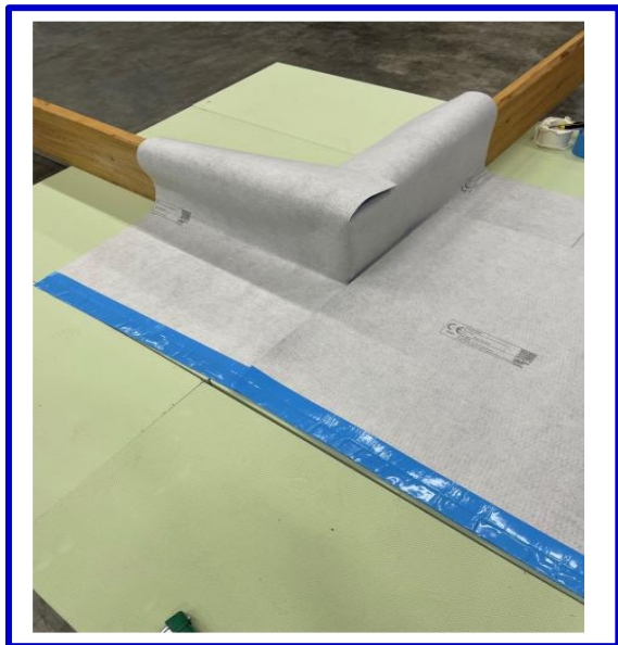
- Paigaldatud välisnurk.
