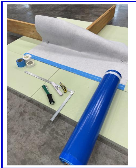
Polyfleece SX® 100 välisnurga paigalduse teostamine raketise äärel.
