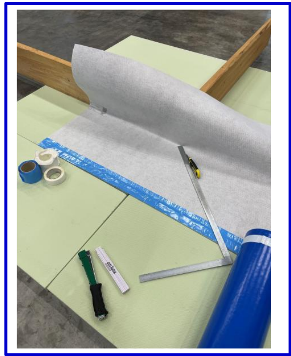
Polyfleece SX® 100 lõikamine 45° nurga all välisnurga raketise nurkades.
