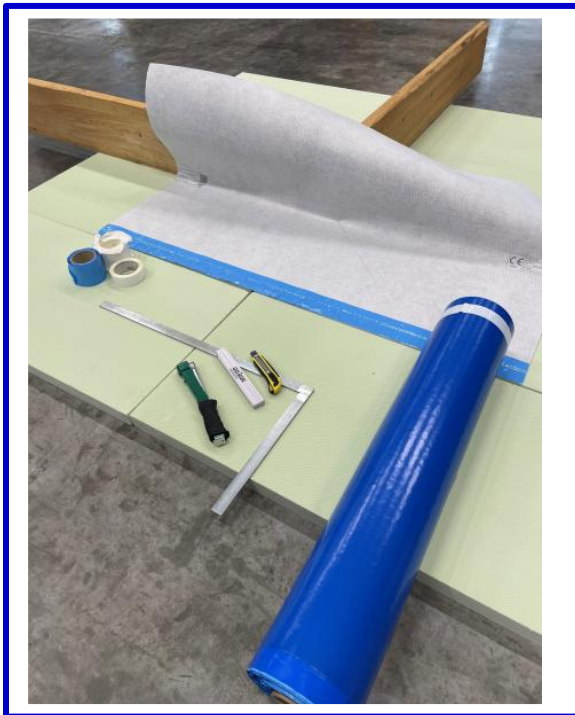
Polyfleece SX® 100 ringpaigalduse teostamine ääreservise raketisele.
