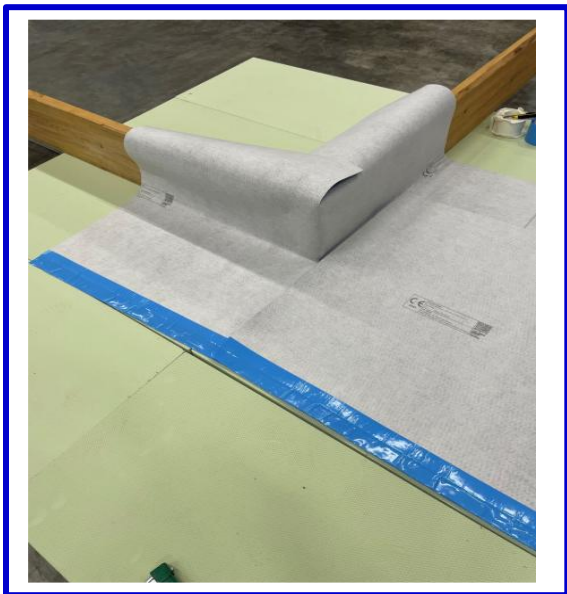
- Paigaldatud välisnurk.
